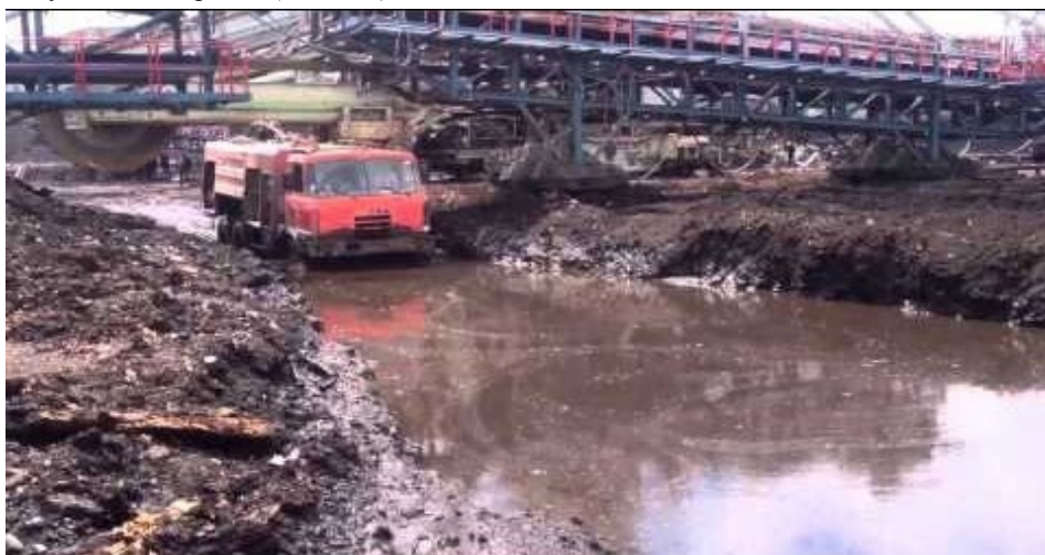
Слика 1. Неодводњен пут
