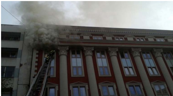
Слика 9 – Пожар на фасади јавног објекта у Скопљу 2018
