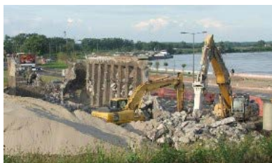
Слика 2 – Рушење зграде
