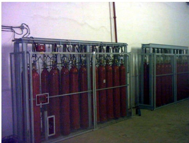
Слика 1 Стационарни систем за гашење пожара угљен-диоксидом (Стари систем)
