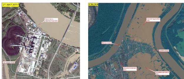
Слика 6. Локација оштећења објеката у зони ТЕНТ и код Забрeжја (извор: UNITAR) Figure 6. Location of structures damage near TENT and Zabrеžje (source: UNITAR)
