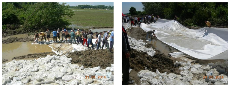
Слика 4. Заштита ножице насипа (извор: ЈВП „Србијаводе“) Figure 4. Levee foot protection (source: PWMC “Srbijavode”)
