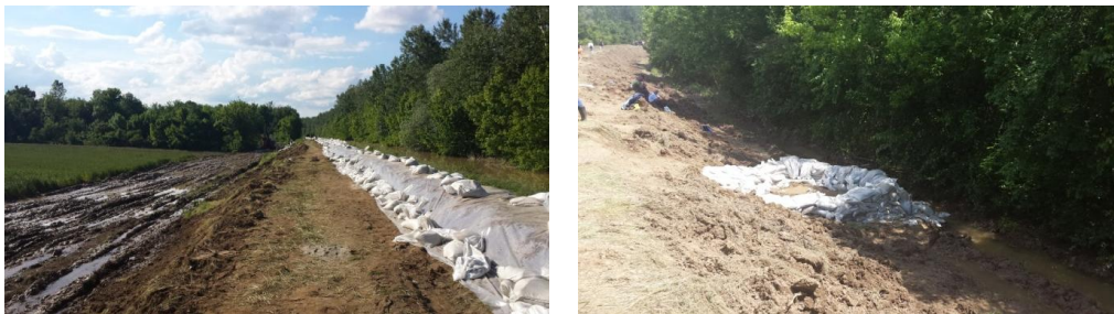
Слика 3. Надвишење насипа и каптирање извора (извор: ЈВП „Србијаводе“) Figure 3. Levee heightening and underseepage relief well (source: PWMC “Srbijavode”)
