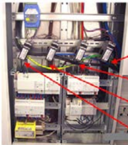
Слика 5 - Пример размештања (монтаже) струјних мерних трансформатора
