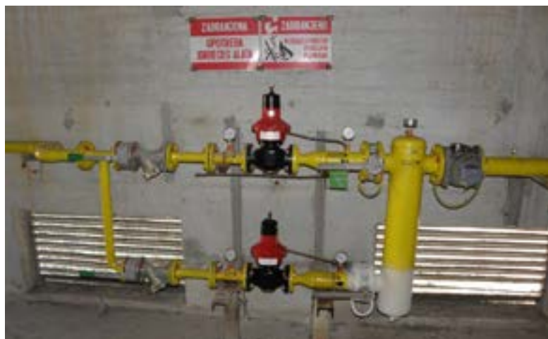
Slika 4. Mjerno regulacijski sklop cjevovoda
