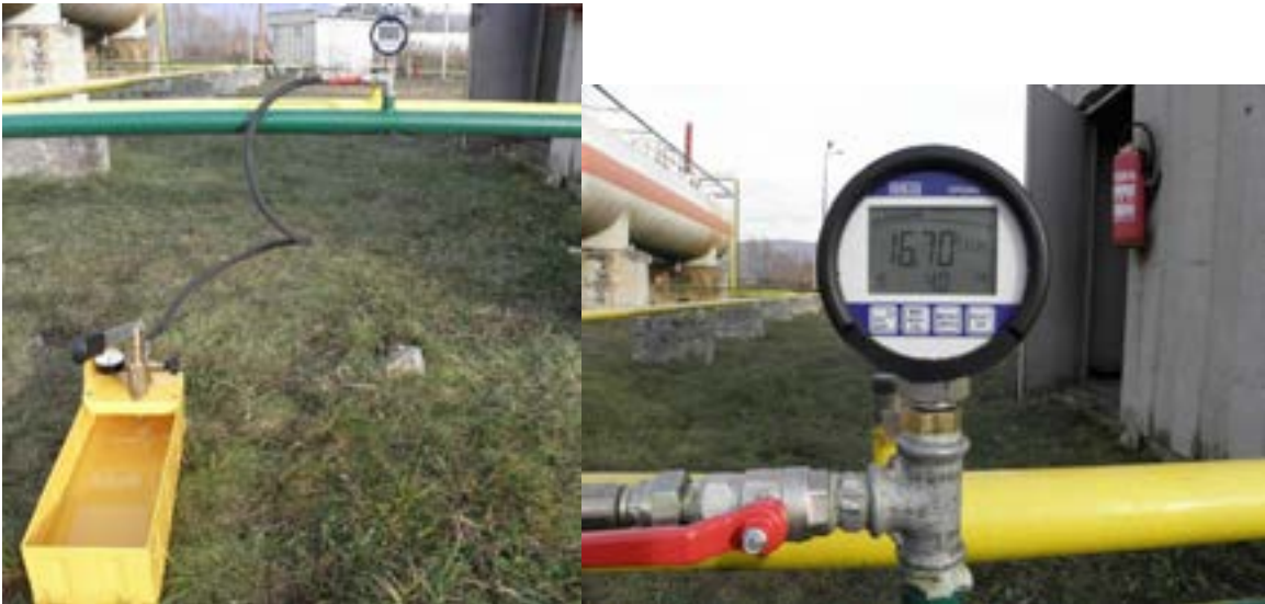
Slika 5. Ispitivanje tlakom, Prvi dio ispitivanja tlakom pri radnom tlaku
