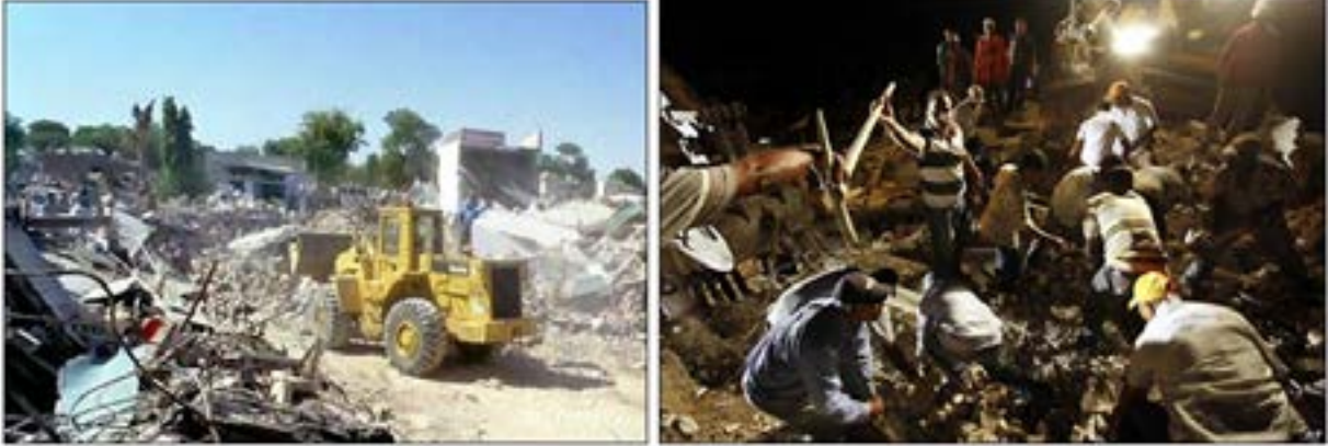
Слика 9 - Чишћење простора помоћу багера [4] Слика - 10 Рашичишавање рушевина ручним алатима [6]
