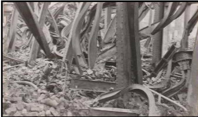
Slika 1 - Primjeri posledica požara čeličnih konstrukcija
