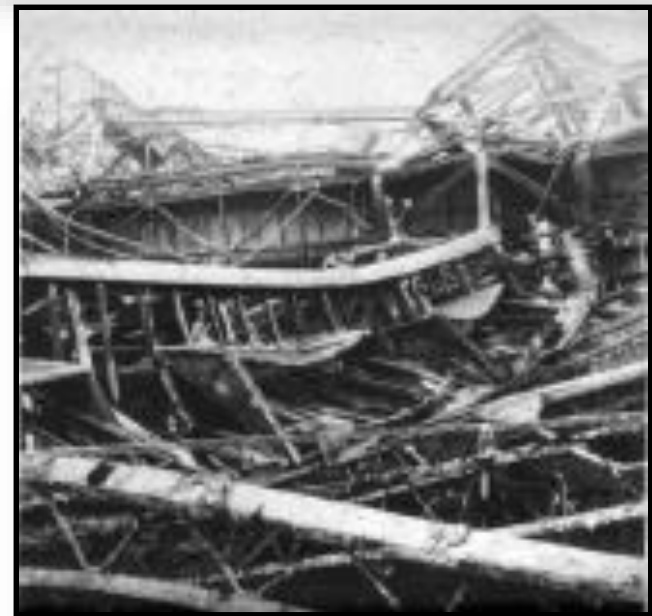
Slika 1 - Primjeri posledica požara čeličnih konstrukcija
