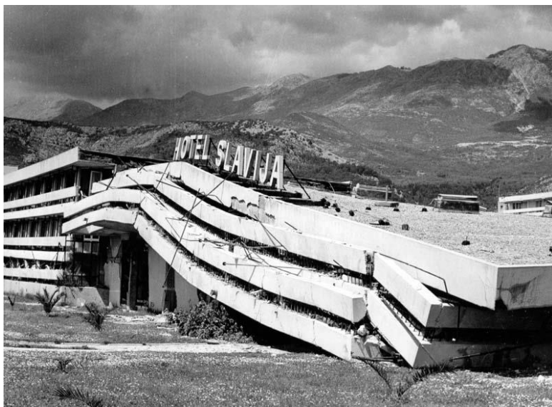
Figura 2. Shkatërrimi i katit të butë, e ndjekur nga shembja e tërë strukturës së Hotelit "Slavija" në Budva pas tërmetit të Malit të Zi në 1979 (R. McGuire, U.S. Geological Survey, 1979)
