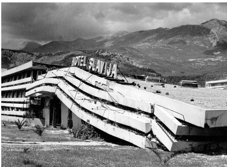
Slika 2. Kolaps „mekog“ sprata, praćen kolapsom cele konstrukcije hotela „Slavija“ u Budvi nakon zemljotresa u Crnog Gori 1979. godine (R. McGuire, U.S. Geological Survey, 1979)
