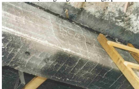
Slika 4. Radikalno odvajanje i otpadanje komada betona (Sloughing off spalling), ploča
