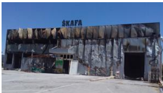
Slika 3. Ulaz u Halu 1. sa ulice
