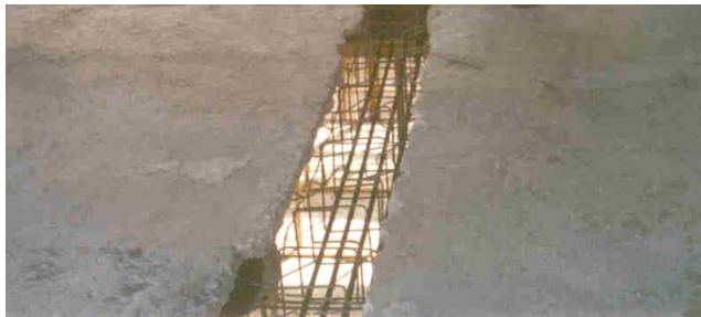
Slika 26. Postavljena armatura za nove greda
