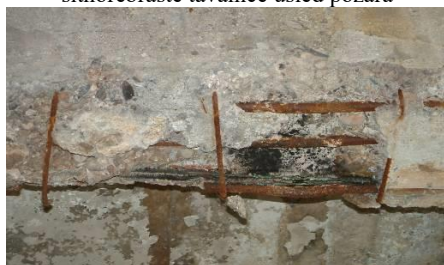
Slika 15. Lokalno duboko otpadanje komada betona i deformisana šipka armature, usled topljenja instalacija unutar poprečnog preseka (levo – greda, desno – ploča)
