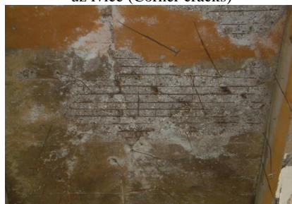
Slika 4. Radikalno odvajanje i otpadanje komada betona (Sloughing off spalling), ploča
