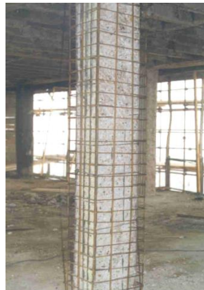
Slike 12 i 13. Postavljanje nove dodatne armature stubova
