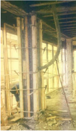
Slika 14. Ugrađivanje betona
