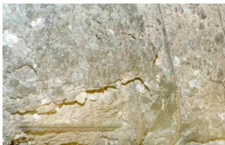
Slika 3. Radikalno odvajanje i otpadanje komada betona (Sloughing off spalling), greda
