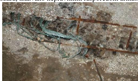
Slika 15. Lokalno duboko otpadanje komada betona i deformisana šipka armature, usled topljenja instalacija unutar poprečnog preseka (levo – greda, desno – ploča)
