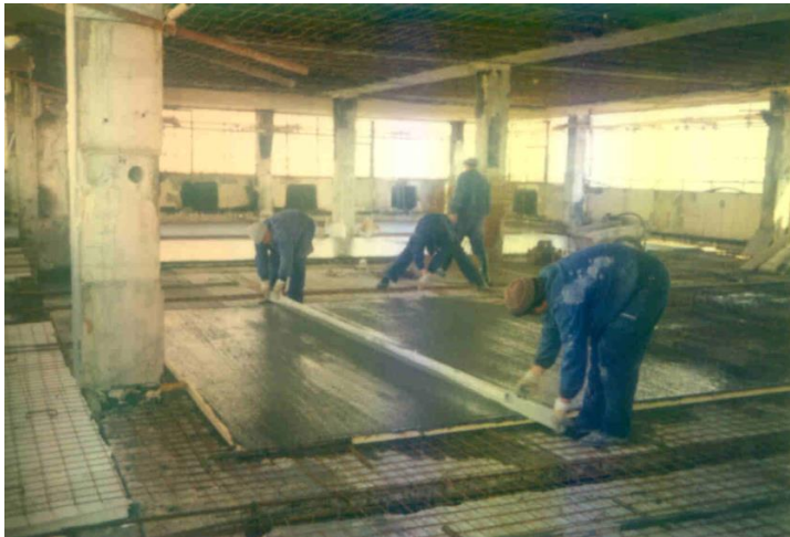
Slika 28. Betoniranje nove ploče
