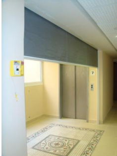
Slika 13. Požarna zavjesa za liftove
