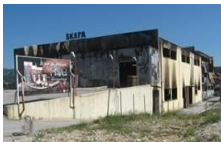
Slika 4. Desna fasada TC u odnosu na glavni ulaz
