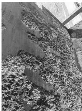
Slika 4. Ljuskanje betona [1]
