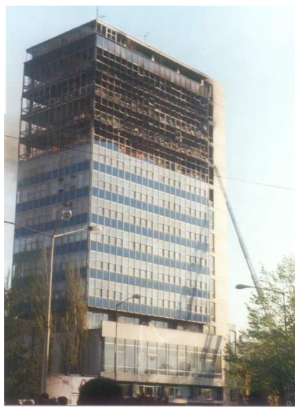
Slika 2. Izgled zgrade nakon požara
