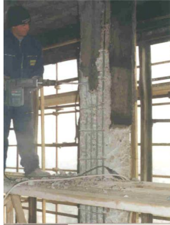
Slike 10 i 11. Uklanjanje oštećenog betonskog sloja sa stubova
