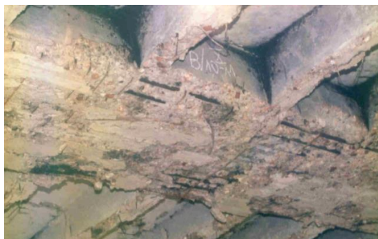
Slika 7. Karakterističan izgled podužne grede nakon požara
