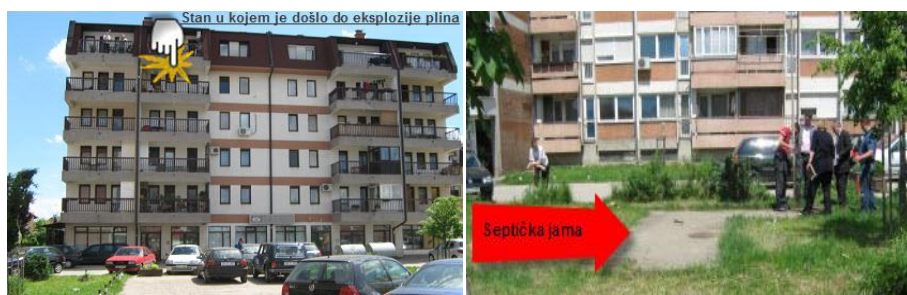
Slika 10. Stan u kome je došlo do eksplozije i položaj septičke jame
